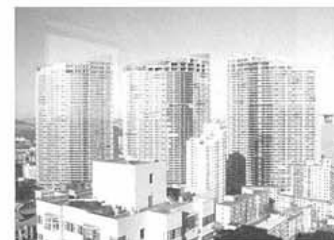
大連市内 大連駅近くのイトンビル（建設中） ショッピング・オフィス・マンションの高層複合ビル
