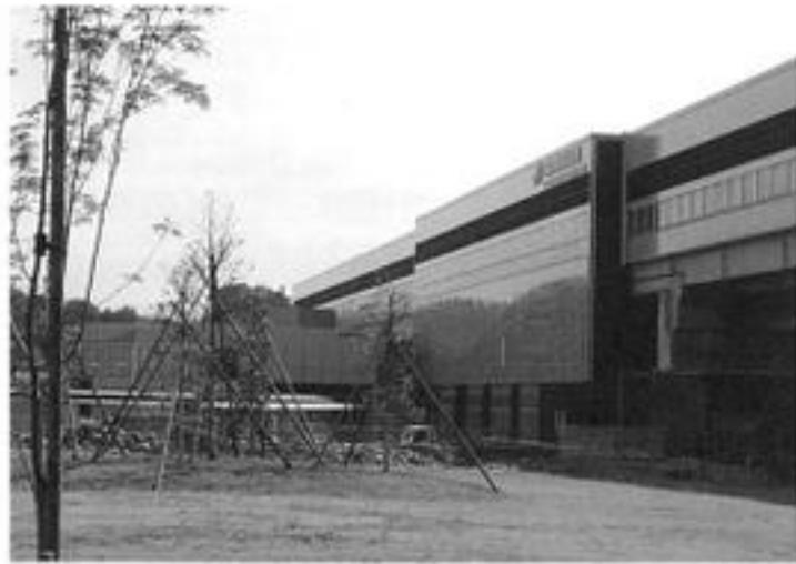
黒部宇奈月温泉駅工事進行状況
