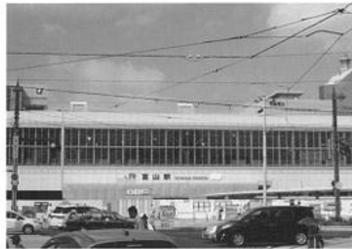
新富山駅工事進行状況
