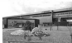
黒部宇奈月温泉駅工事状況 (H26.11.22)
