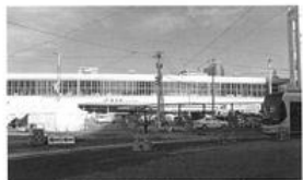
富山駅工事状況 (H26.11.22)
