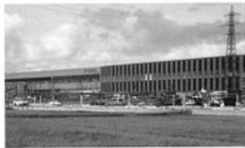
新高岡駅工事状況 (H26.11.22)
